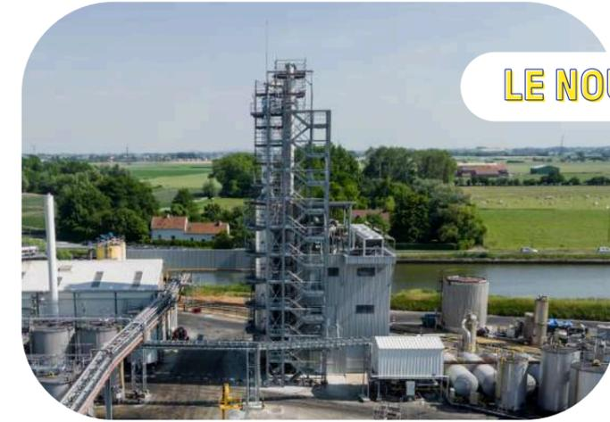
C'est le point culminant du site, le desodo Andreotti, achevé en 2023, a la capacité de traiter 300 tonnes de produit par jour. En termes d'écologie, il permet de réduire la consommation d'eau de 75 % et de diviser par six la consommation de vapeur.
